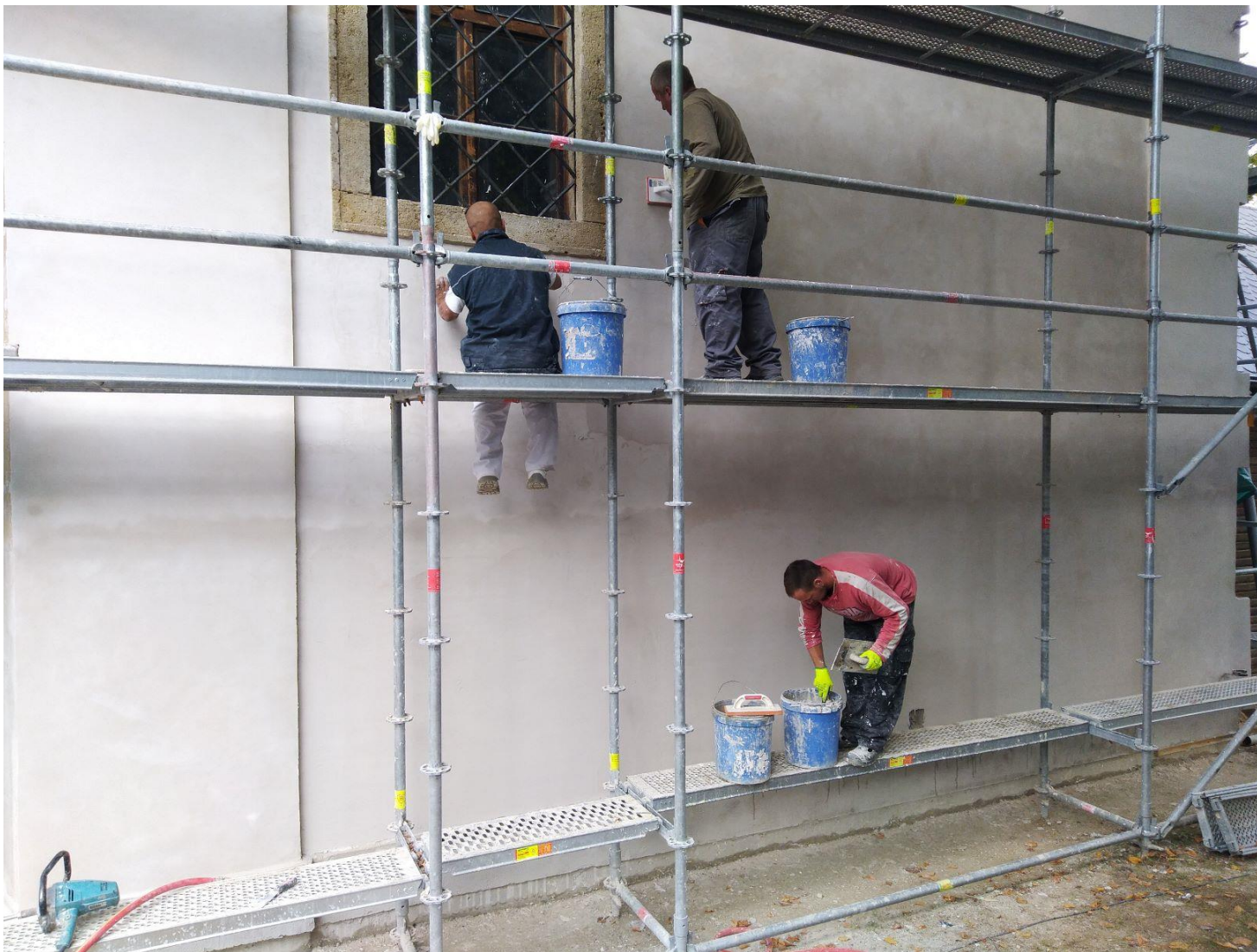
Začísťovanie povrchu fasády jemným štukom
