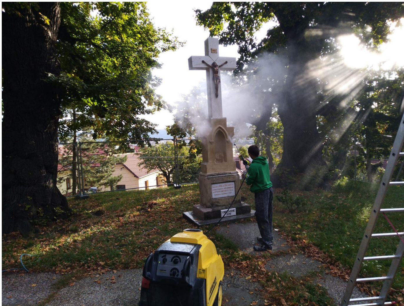
Čistenie kamenného kríža pred Kaplnku vysokotlakým prúdom zmesi vody a pary
