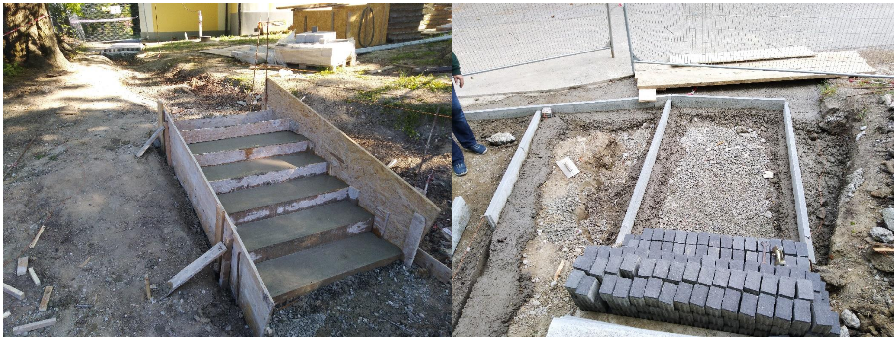
Betonáž základov nových schodov za Kaplnkou, betonáž obrubníkov pred schodiskom a rampou pre peších.
