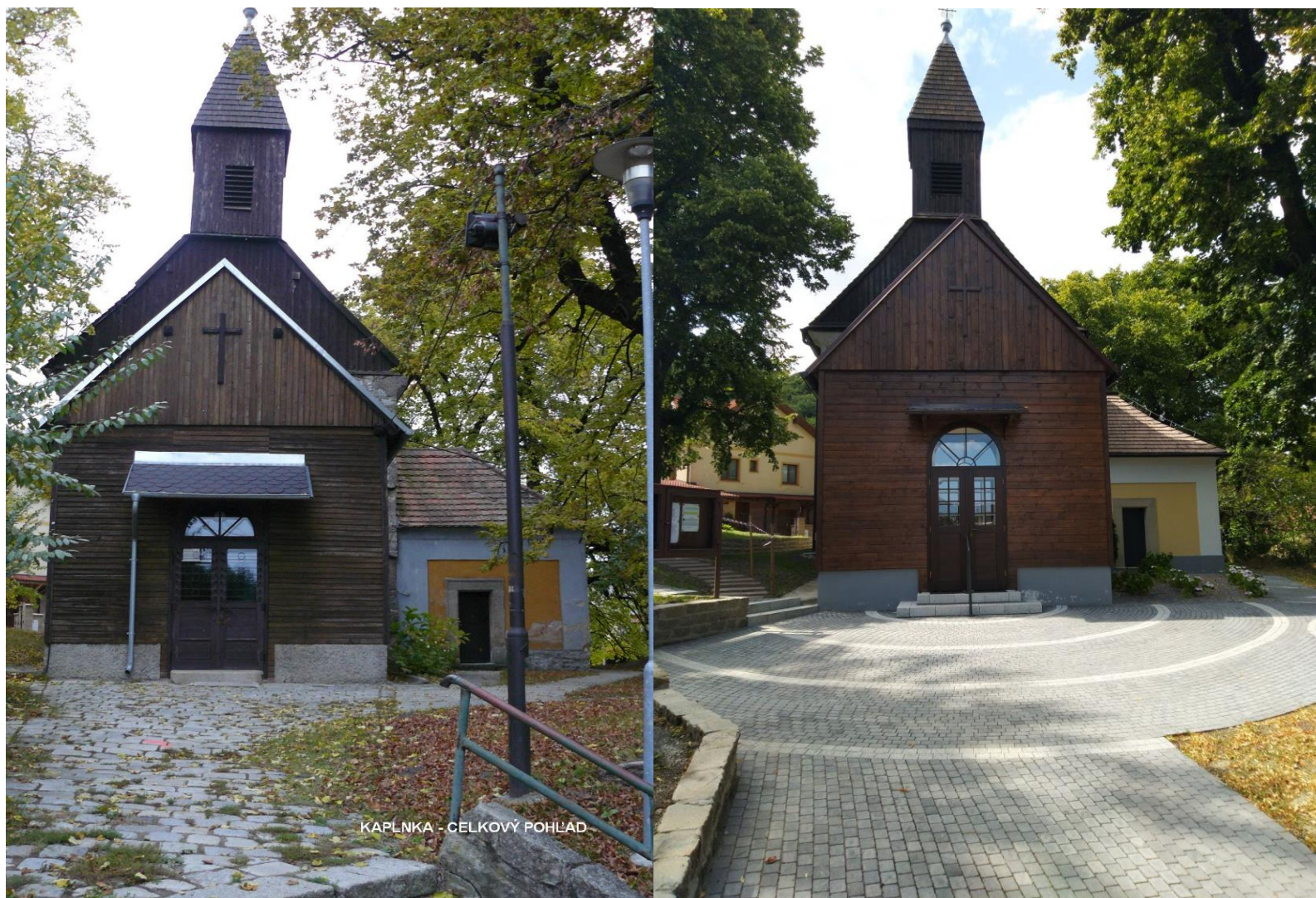
Kaplnka pred obnovou a po obnove...
